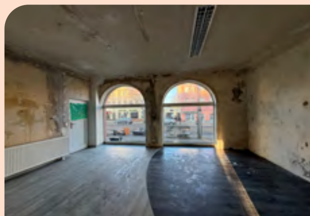
Vor und nach dem Umbau in der August-Bebel- Straße 118
