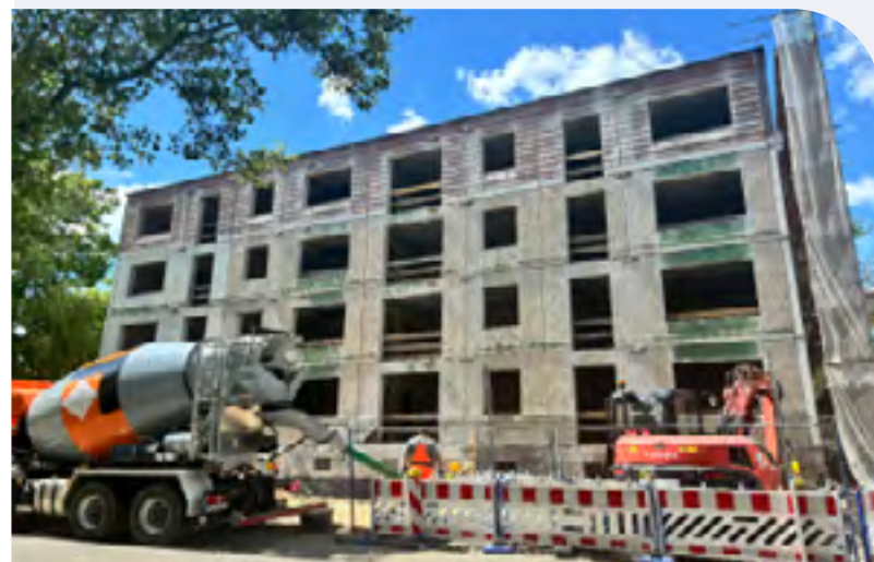
Eine reinste Baustelle – alle Gewerke wissen wo es lang geht
